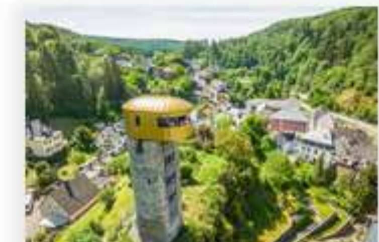
Beilsturm in Neuerburg
