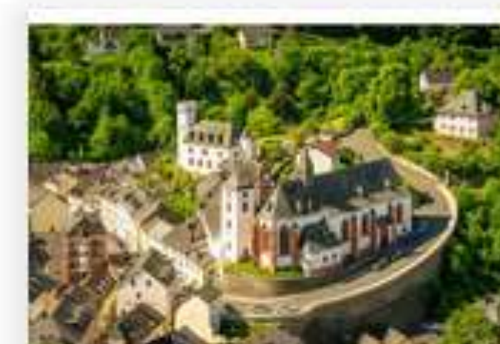
Blick über Neuerburg
